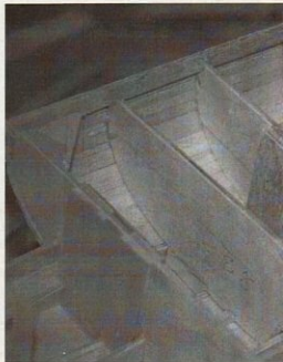
Mise en place des 1/2 fourreaux de clef d'aille.
