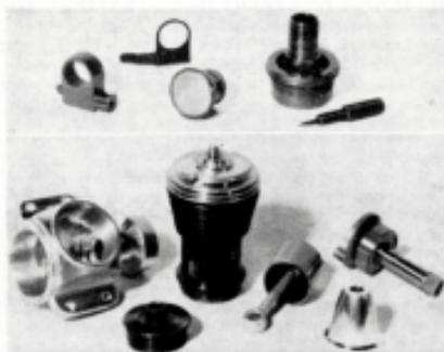
La photo ci-contre permet de se rendre compte du très petit volume du vilebrequin ainsi que de l'allure du piston. La photo du dessus montre le carburateur en pièces détachées. Remarquez le pointeau d'une pièce et le gicleur intégral. Sur la photo du moteur de l'autre page, on distingue l'écrasement de la bielle.
